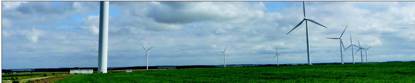
➔ Vue panoramique sur le parc éolien Le Val de Noye I & II au sud de Louvrechy
